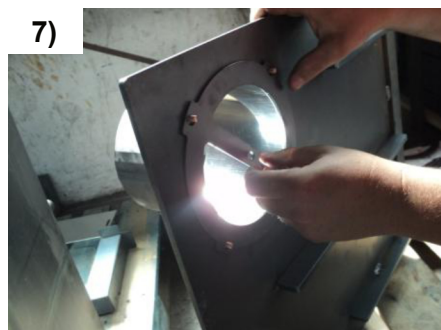
7) Danach muss die Verlängerung der Schornsteinableitung mit dem Schutzring befestigt und mit den verbleibenden 4 Schrauben festgezogen werden.
