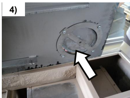
4) Entfernen Sie den runden Schutzdeckel
