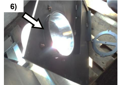
6) Nun kann die Verlängerung der Schornsteinableitung in das Loch eingesetzt werden
