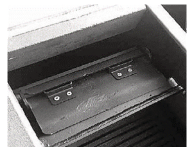
Rauchrichter (17) geöffnet ⇒ die Kesselleistung wird deutlich reduziert
